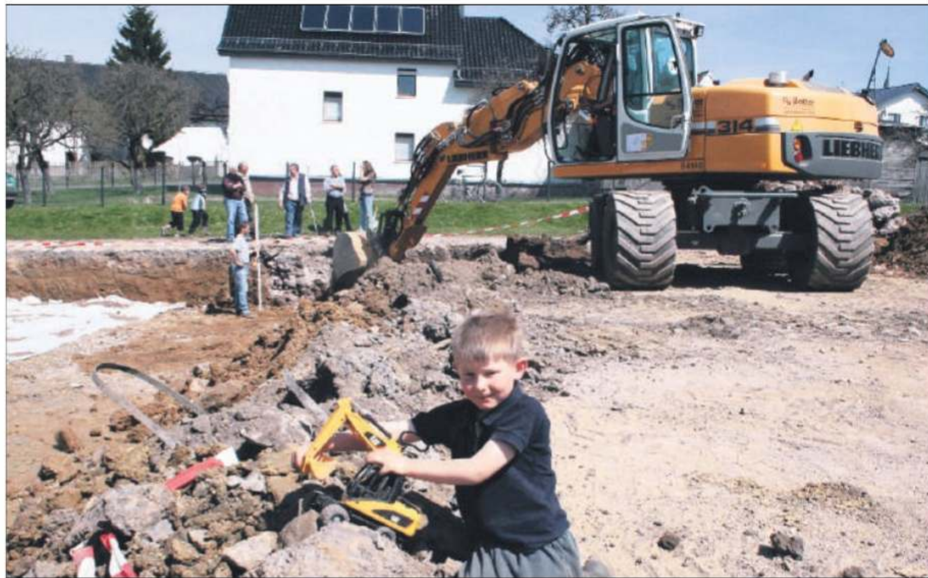
Große und kleine Helfer tummeln sich an der Baustelle in Blankenheimerdorf. Tom (vorne) eifert seinem Vater, Baggerführer Heiko Bieger, nach und trägt schon mal kleine Erdhügel ab. (Foto: Gempfer)
