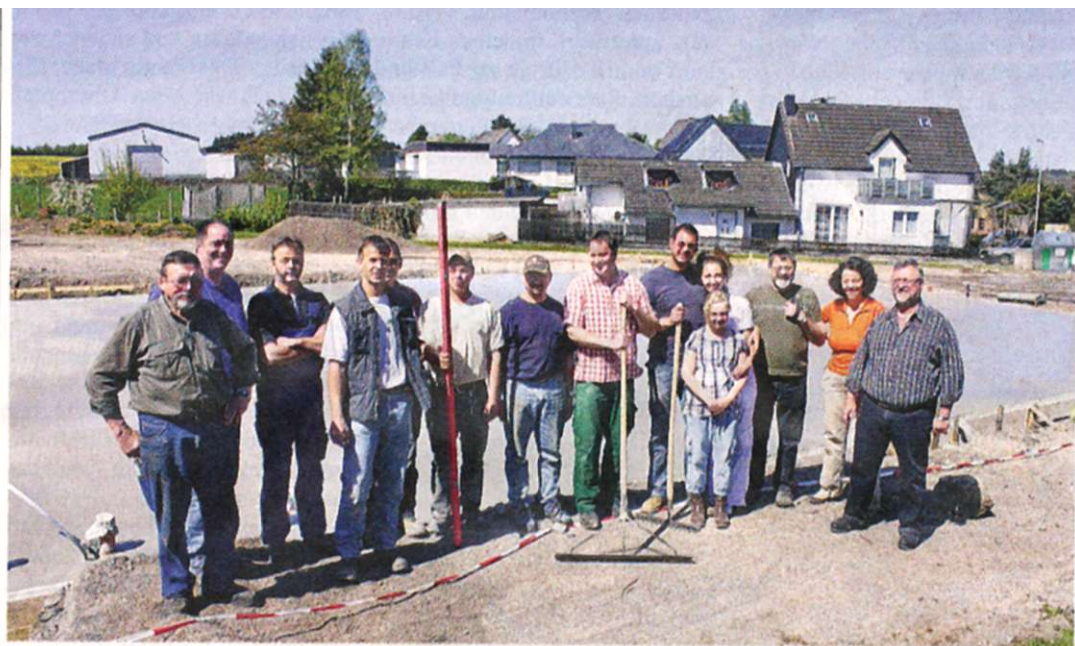
An Pfingstsonntag goss rund ein Dutzend freiwilliger Helfer die Bodenplatte für das Bürgerhaus in Blankenheimerdorf. Wenn alles klappt, soll zur Kirmes die Einweihung gefeiert werden. BILD: PUDERBACH
